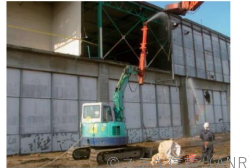
湿潤化の例(散水)
