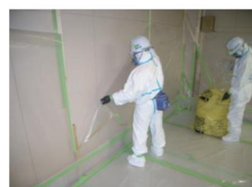
養生シートの撤去
